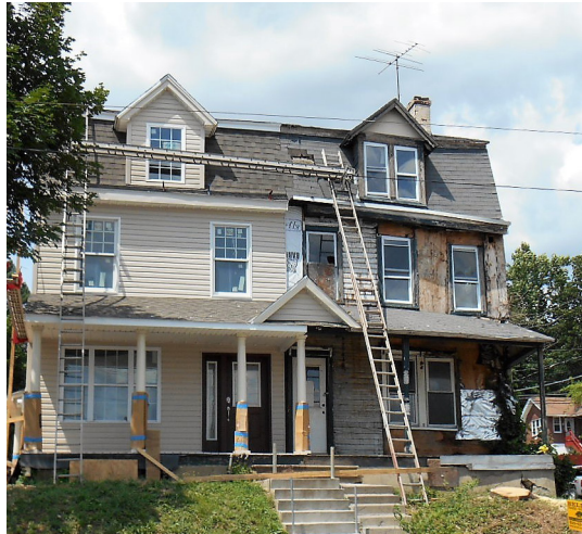
Rehabilitación de una vivienda en Allentown
