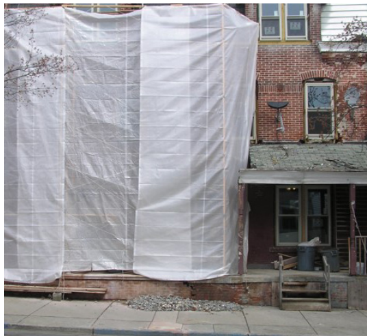
Renovación de la fachada de una vivienda
