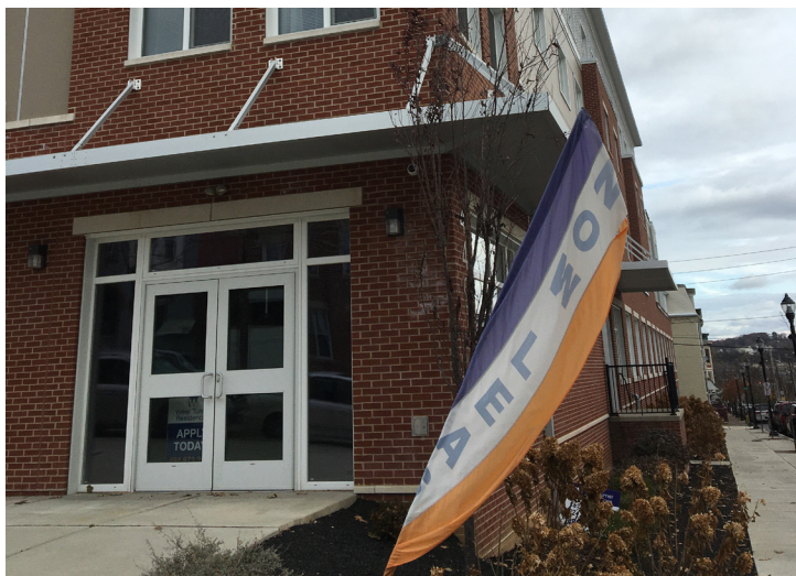
Viviendas asequibles para mayores en Allentown
